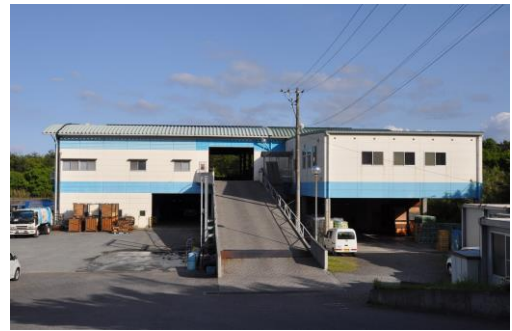
本社工場（そおりサイクルセンター）
